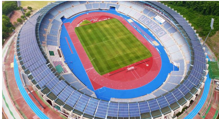
1,000kW급 원형 슬라이스의 루프탑 현장
